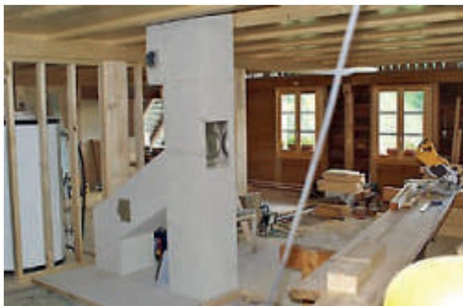
Abgasanlage im Schacht mit Reinigungsöffnung, Doppelfutterrohr und weiterem Anschluss von einem zweiten Zug mit Schacht
