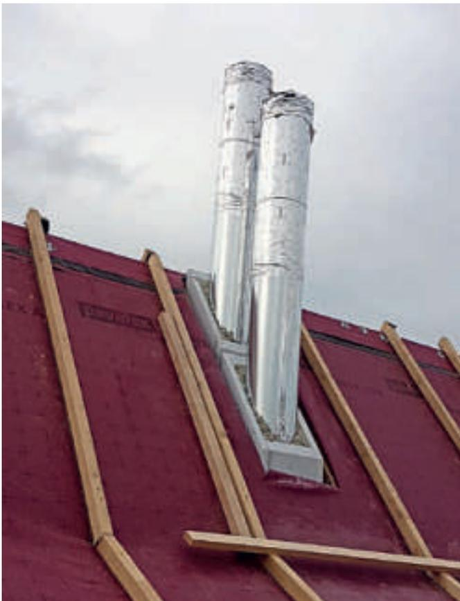
Dachdurchführung von zwei Abgasanlagen in zwei Schächten
