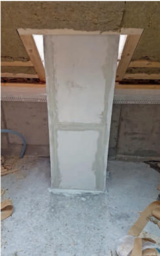
Dachdurchführung mit Schacht und Wechsel in der Sparrenlage
