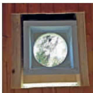
Aussenwand aus Holz mit eingezettem Brandschutzelement
