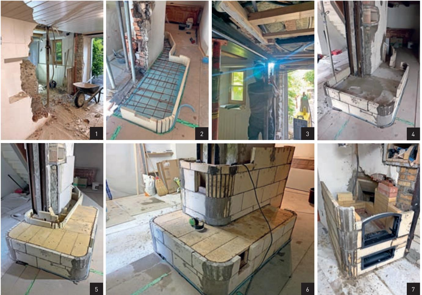
1. Die Zwischenwand wird abgebrochen, die Wand im oberen Stockwerk muss abgefangen werden.
