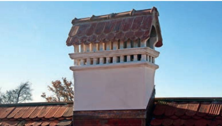
Der fertige Kaminhut auf den drei Abgasanlagen, die als Block durch das Gebäude geführt wurden.
