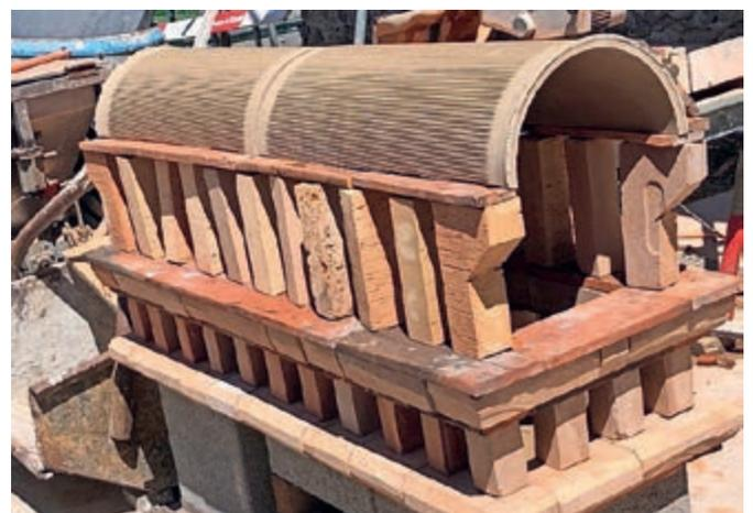
Ein aufgeschnittenes Schamotterrohr bildet die Grundlage für den Abschluss mit den Dachziegeln.
