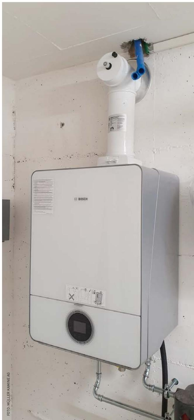
Aufgrund der MuKE-Einführung werden immer weniger Öl- und Gasfeuerungen und somit auch weniger Abgasanlagen installiert. Das Bild zeigt eine Gas-Zentralheizung mit sanierter Abgasanlage.
