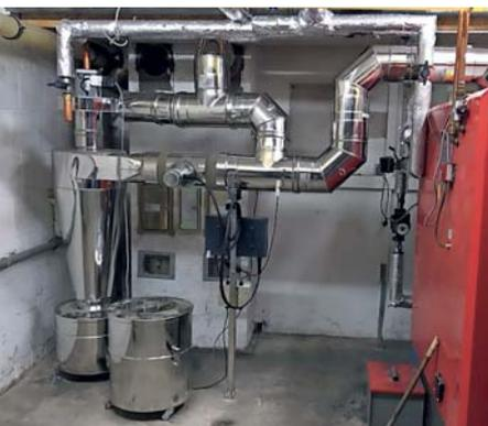
Der Partikelabscheider Cyclojekt reduziert den Staubanfall einer Pelletheizung eines Mehrfamilienhauses deutlich. Das Gerät, eine Entwicklung des Abgasspezialisten Kutzner + Weber in Zusammenarbeit mit dem Fraunhofer-Institut für Bauphysik IBP, konnte problemlos in die Anlage eingebunden werden.
