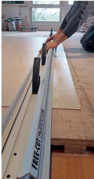
Der Schnitt muss präzise nach Massaufnahme erfolgen.
