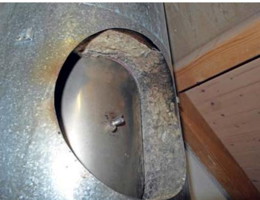
Mineralwolldämmung an einer Abgasanlage in einem Dachraum: Es stinkt durch die Täferdecke ins darunterliegende Schlafzimmer.
