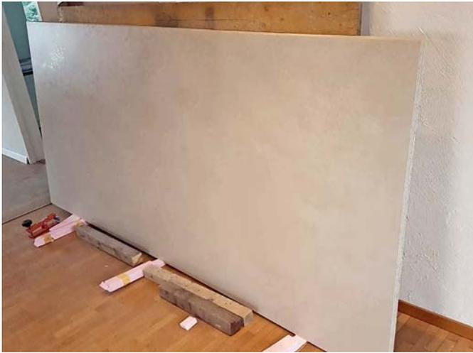
Die Lagerung der Platten erfolgt stehend und ohne Durchbiegung.
