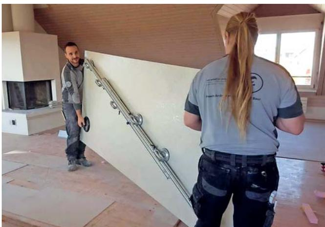
Grossformat-Keramik muss mit Montagehilfen sorgfältig transportiert und verlegt werden.
