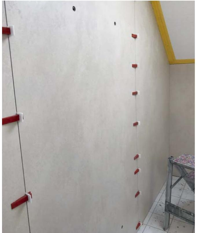
Mit speziellen Versetzkeilen werden die Platten verlegt und Fugenstösse sauber ausgerichtet.
