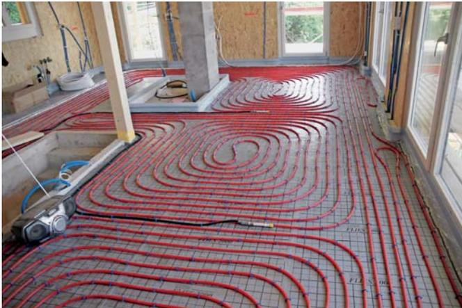
Bodenheizungsrohre werden bifilar reversierend verlegt, somit ergibt sich eine gleichmässige Temperaturverteilung im Boden. Dies ist wichtig bei niedrigen Vorlauftemperaturen
