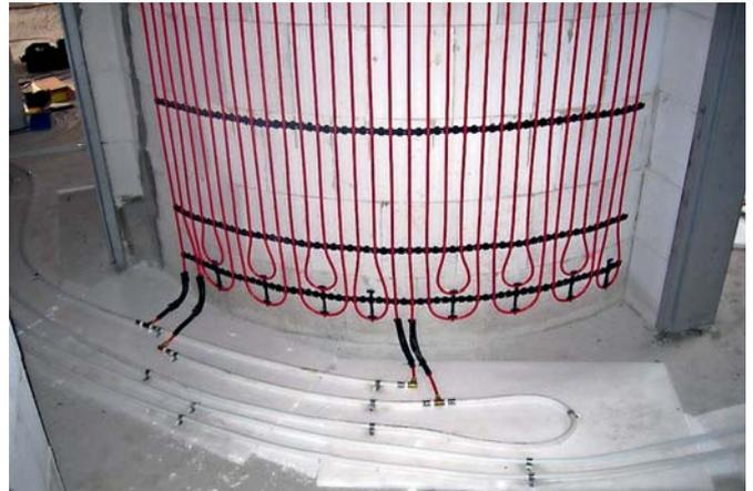
Die Wandheizung ist auf einem Porenbeton aufgebracht und wird mit Grundputz verputzt. Anschliessend kann ein Deckputz oder ein keramischer Belag aufgebracht werden. Eine gute Anwendung mit Keramik sind Nasszellen, natürlich mit der dazugehörigen Abdichtung.
