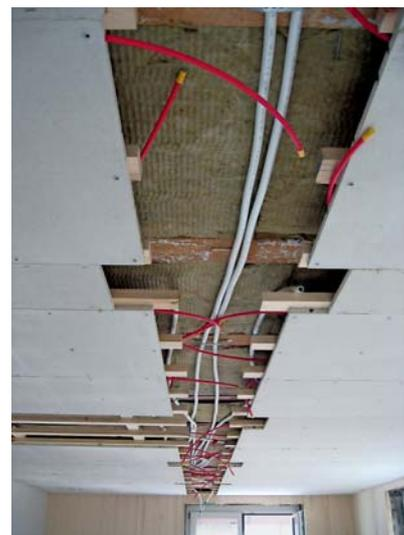
(rechts) Deckenheizung im Trockenbau. Die Heizungsrohre sind fertig in der Gipsplatte verlegt und verspachtelt. Das gleiche System wird auch an der Wand verwendet.
