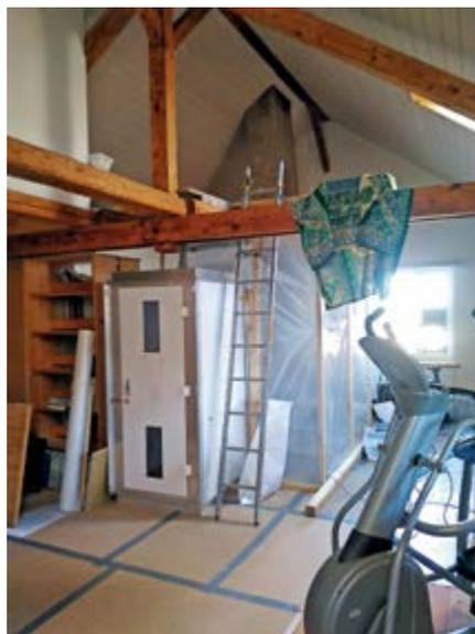
Aufgebaute Zone von aussen mit Schleuse, rechts schlecht sichtbar das UHG mit der Öffnung im Fenster, wo der Schlauch für das Absaugen der gereinigten Luft montiert wird.
