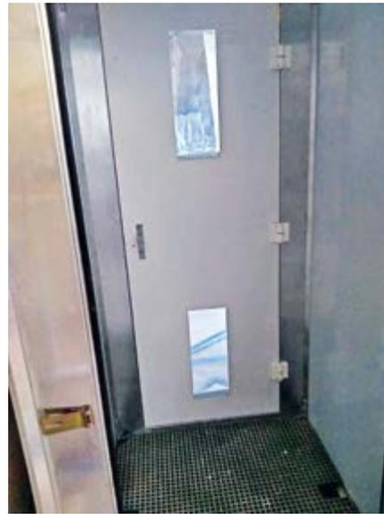
Schleuse von innen mit Kompensationsöffnungen in der Aussentüre. Hier werden die Schuttsäcke einzeln deponiert, allenfalls mit Wasserspritze abgeduscht, Innentüre geschlossen, danach wird die Aussentüre geöffnet und der Sack kann abtransportiert werden. Der Unterdruck bleibt so immer erhalten.
