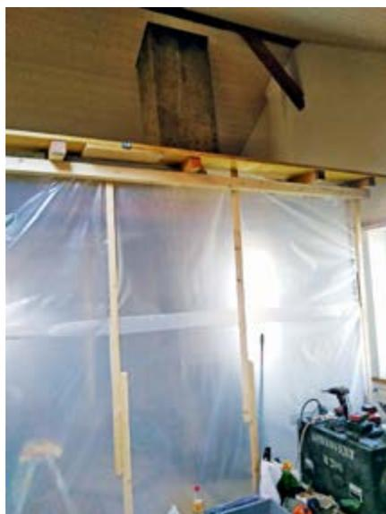
Zonenkonstruktion mit begehbarem Dach zum Verputzen des Kamins
