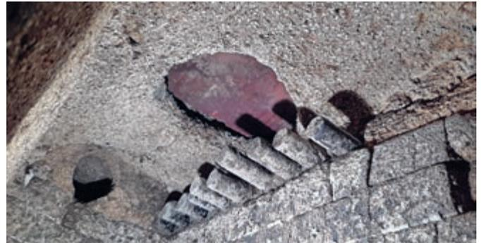
Feuerraumdecke mit den oberen Dampfrohren / Gueulardschieber geschlossen / Direktzugöffnung hinten.
