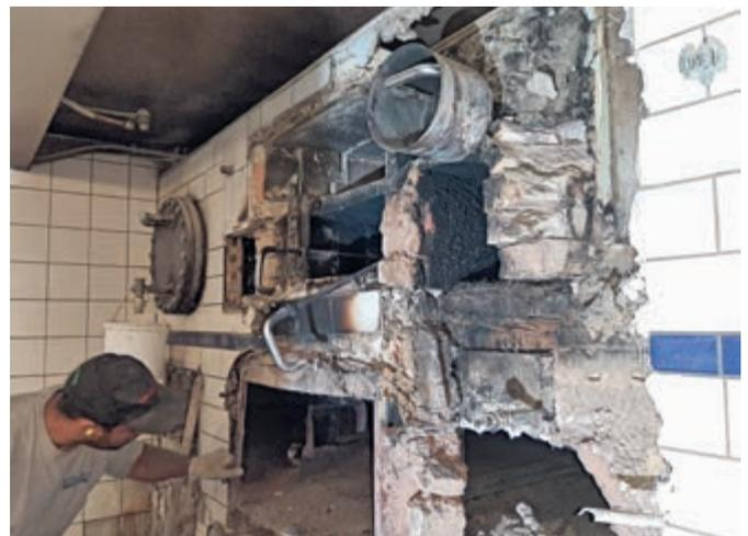
Obere Armaturen sind bereits demontiert und deponiert. Hinten Boiler Länge 250 cm.
